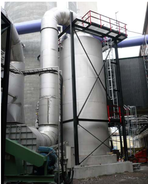
Рисунок 1. Сосуд системы патронных фильтров грануляционной башни нитрата аммония.
